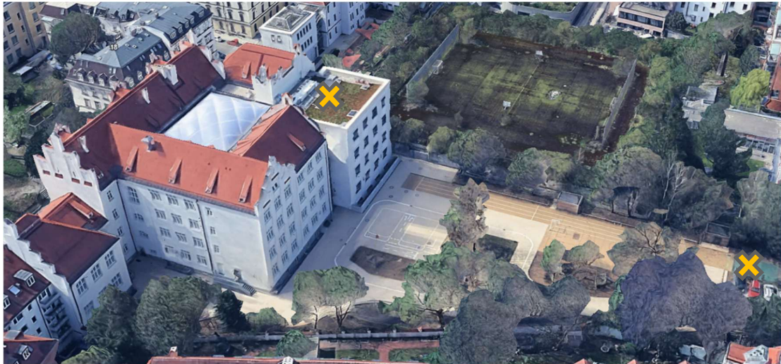
Abbildung 13: Synthetisches Luftbild der Grundschule an der Haimhauserstraße (Google Earth) im Quartier Münchner Freiheit mit möglichen Aufstellorten für Container-Wärmepumpen
